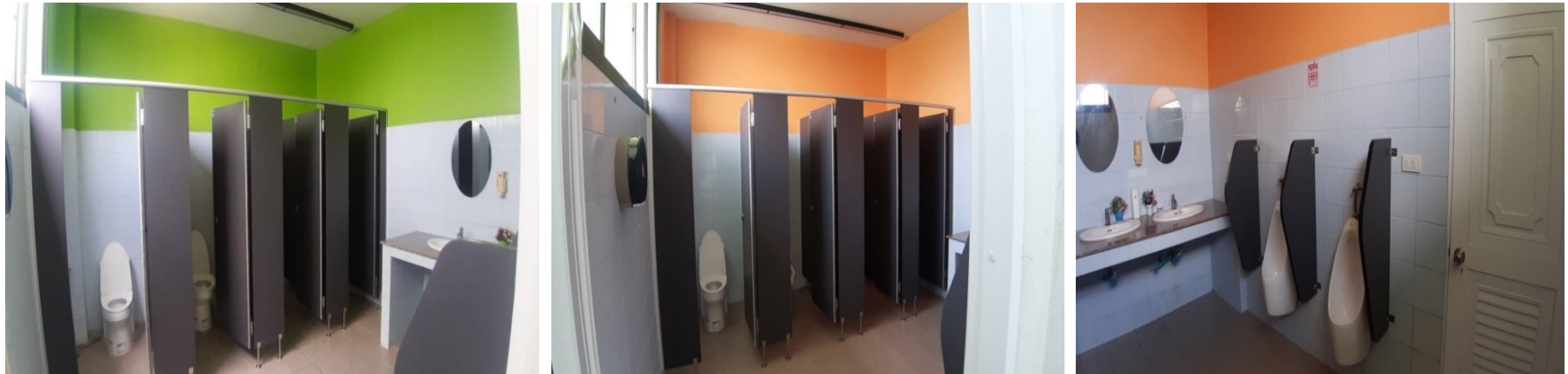
๗. โครงการปรับปรุงซ่อมแซมห้องน้ำอาคารสำนักงาน ชาย-หญิง ทั้ง ๓ ชั้น งบประมาณ ๔๙๐,๐๐๐.-บาท
